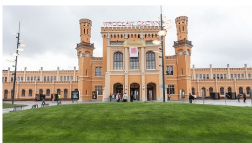
Rys. 10 - Dworzec Wrocław Główny po remoncie Źródło: http://www.wroclaw.pl/
